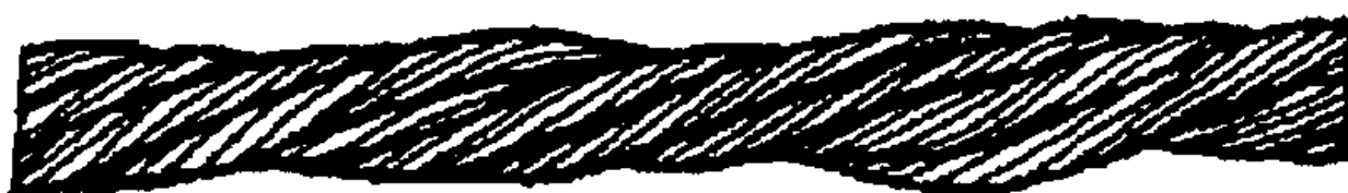
Рисунок 6. Поверхностная коррозия проволок каната крестовой свивки
